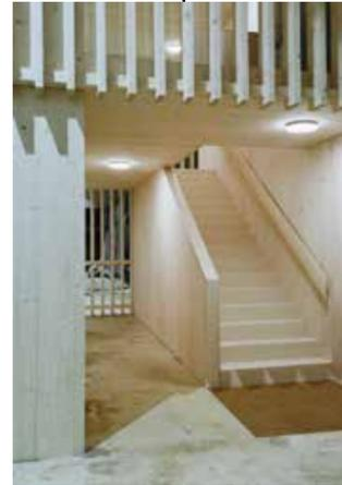
Vorgefertigt und in kurzer Zeit aufgestellt: Die Konstruktion besteht aus Brettsperrholzdecken, Träger und Stützen sind aus Brettschichtholz. Auch Treppe und Kücheneinbauten sind aus Tanne und Fichte gefertigt.
