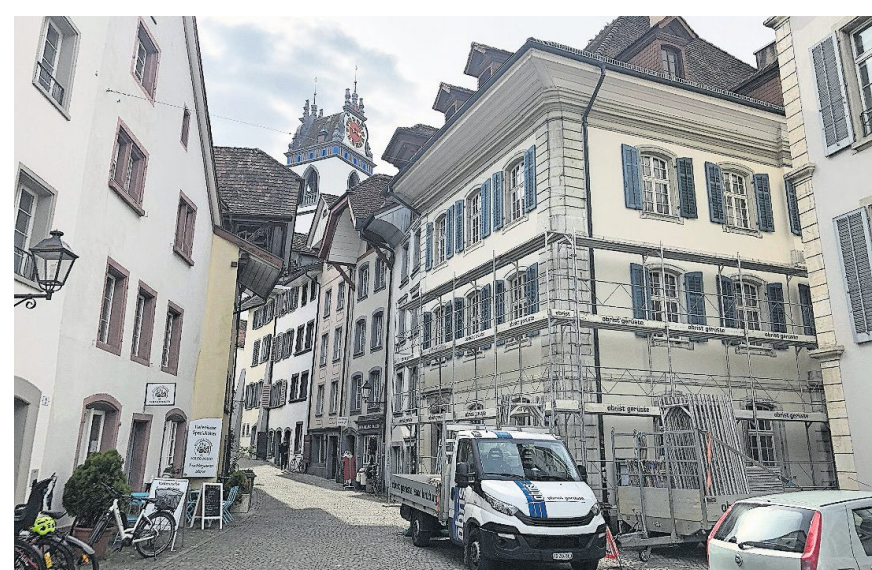
Das christkatholische Pfarrhaus am Adelbändli wird energetisch saniert. Bild: ksc
