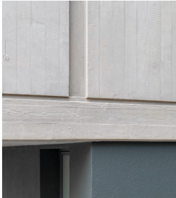
Optisch einwandfrei – mit StoCrete Mörtel und mit StoCryl Oberflächenschutz wurde der Werterhalt der Hochhausfassade Bilander gesichert.
