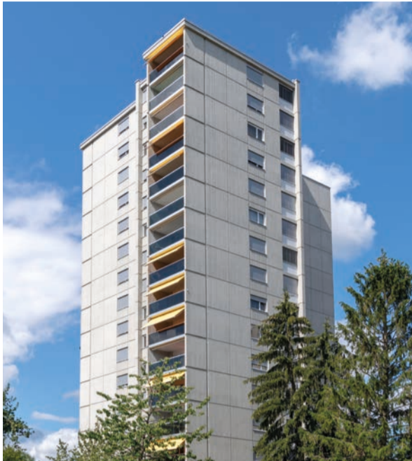
Optisch einwandfrei – mit StoCrete Mörtel und mit StoCryl Oberflächenschutz wurde der Werterhalt der Hochhausfassade Bilander gesichert.
