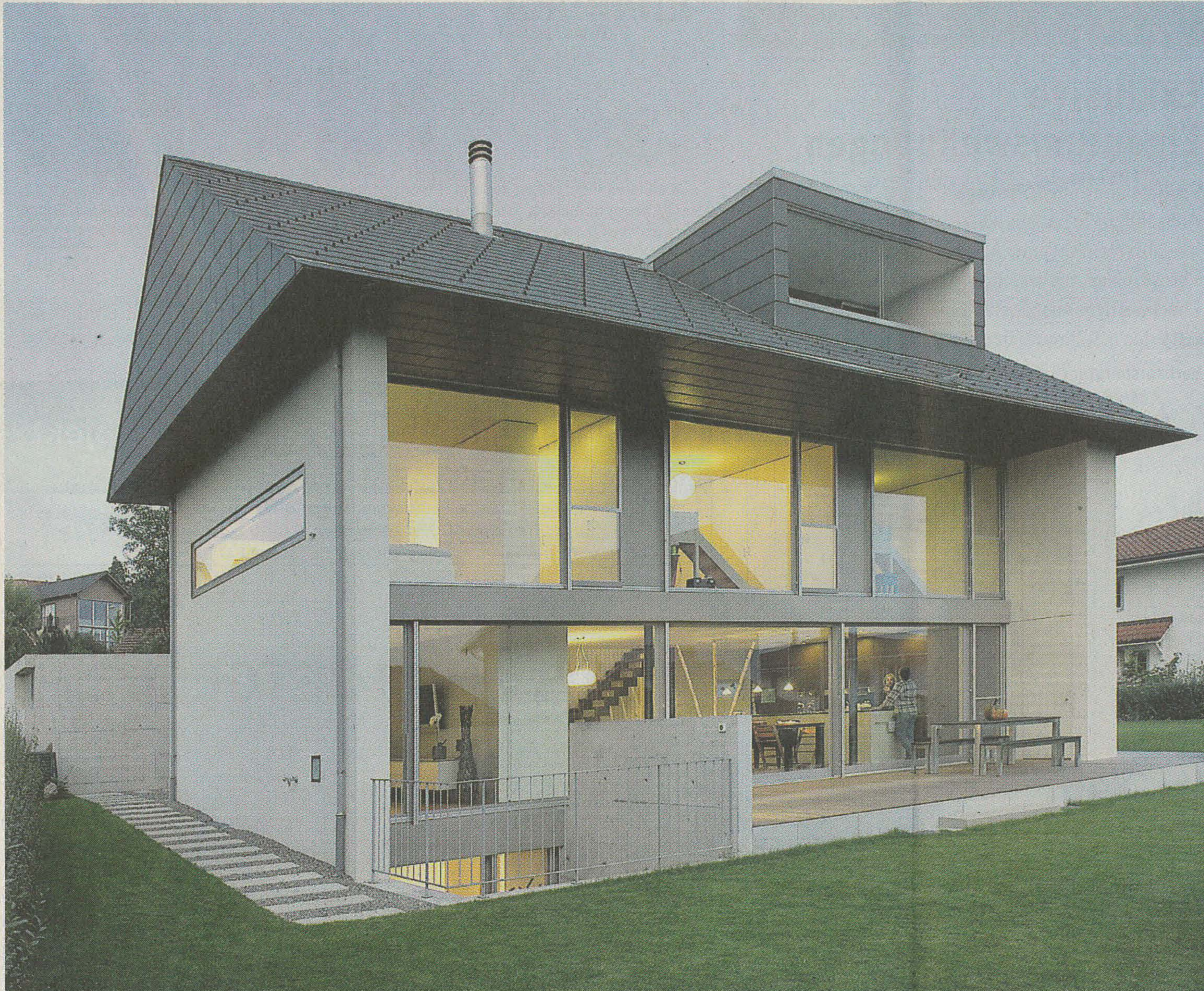
Neues Einfamilienhaus am Rand des Ortskerns von Besenbüren: Moderne Antwort auf überkommene Regeln
